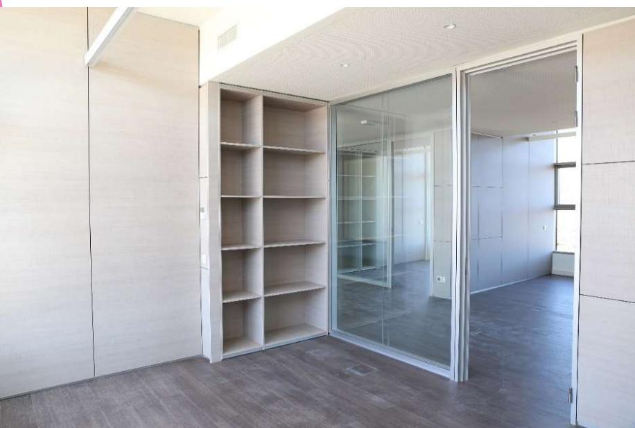
Paredes divisórias opacas com porta de vidro duplo integrada
