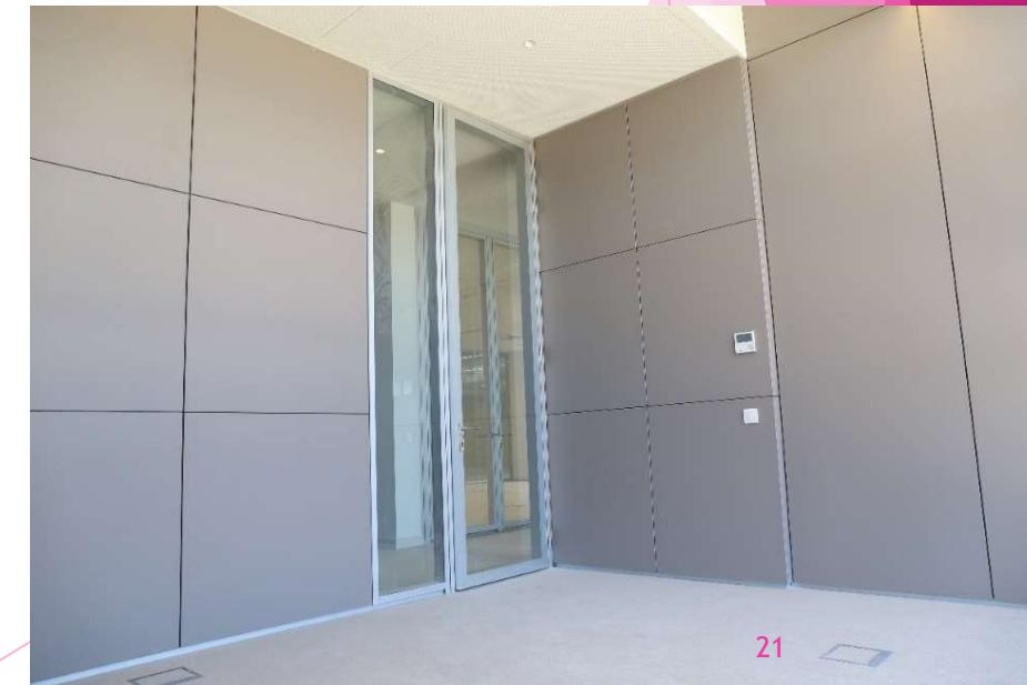
Porta opaca integrada em forro de parede opaco
